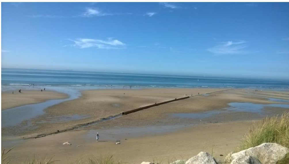
Figure 5 : Canalisation d'approvisionnement (photo Egis – Dune d'Aval 2016)
