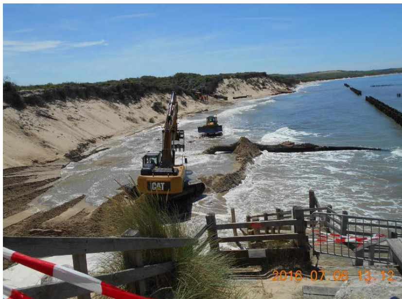
Figure 7 : Dépotage du sable (photo Egis – Dune d'Aval - 2016)
