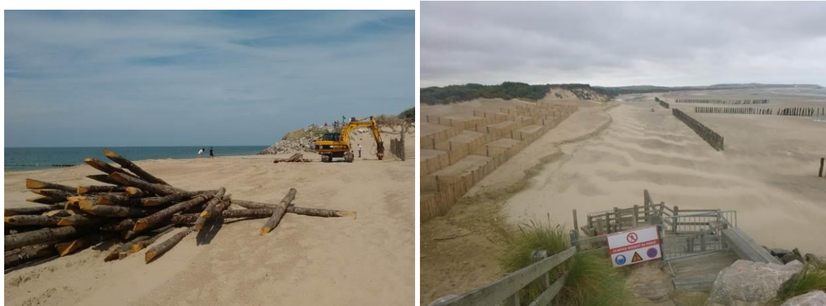
Figure 9 : Mise en place des pieux bois, ganivelles (photo Egis – Dune d'Aval - 2016)
