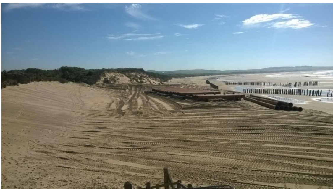
Figure 6 : Repliement de la canalisation d'approvisionnement en sable (photo Egis – Dune d'Aval - 2016)
